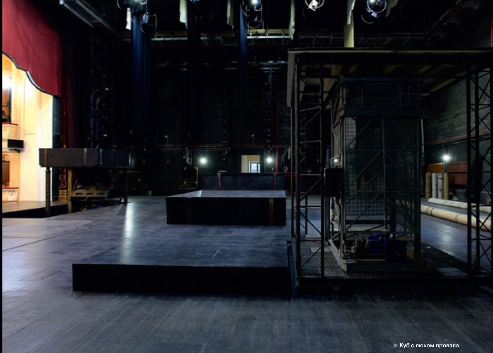
■ Вся сцена состоит из двадцати подъемно-опускных платформ
